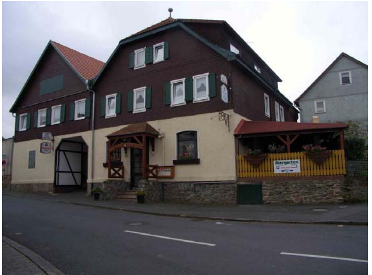
Gasthaus mit Biergarten rechts, Toreinfahrt links
